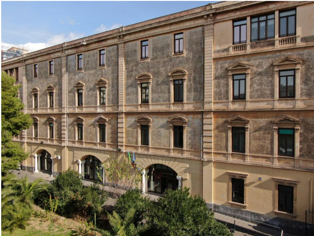
Fig. 1 e 2 - Due immagini della facciata del palazzo che ospita il TAR Catania
