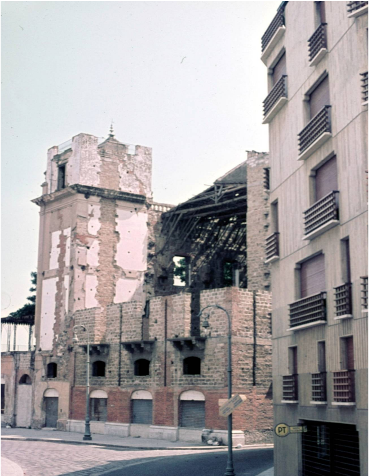
Palazzo Benso, prima dell'inizio dei lavori di ristrutturazione
