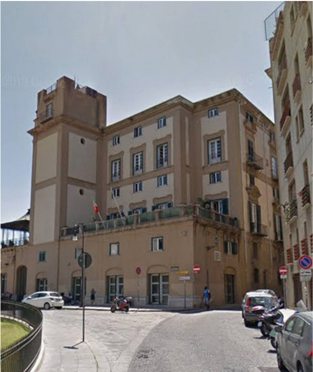
Palazzo Benso dopo i lavori, adibito a sede TAR
