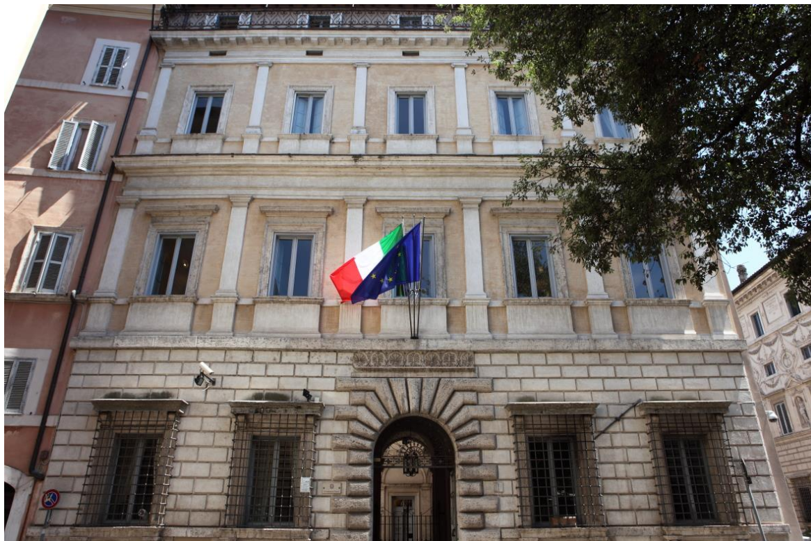
Palazzo Ossoli – Facciata
